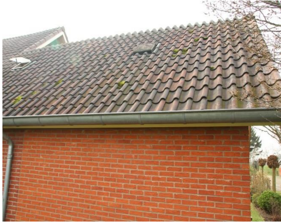
Dakpannen sluiten strak op elkaar aan.
