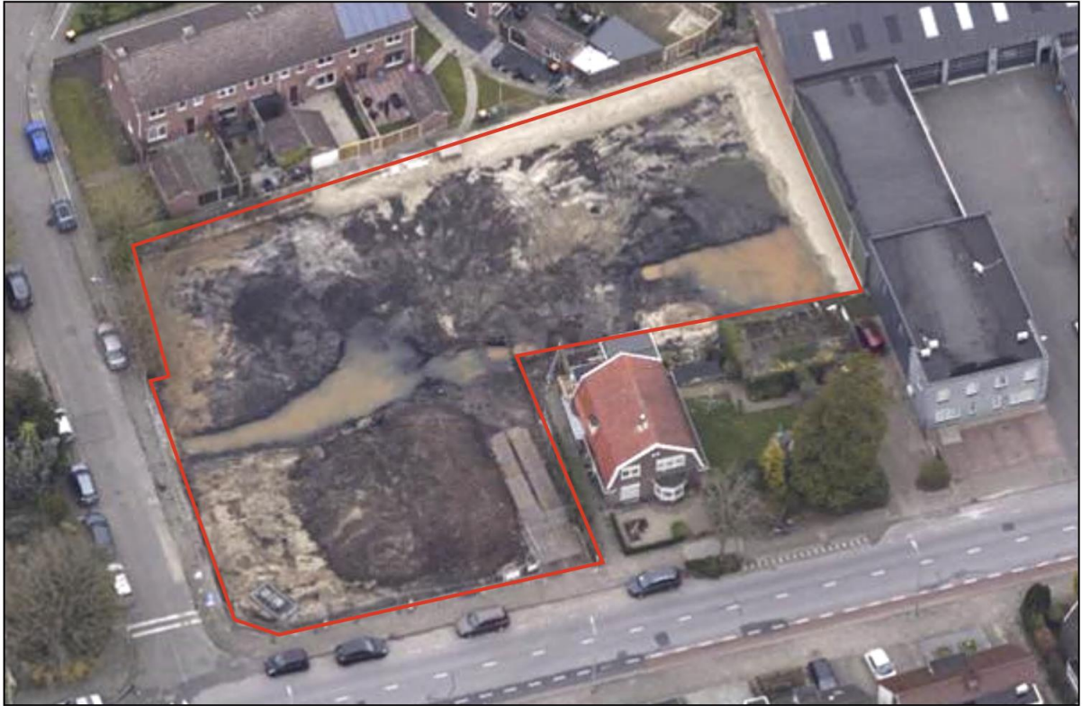
Afbeelding 2.2 Luchtfoto huidige situatie plangebied (Bron: PDOK)
