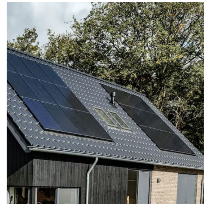
Vlakken met zonnepanelen
