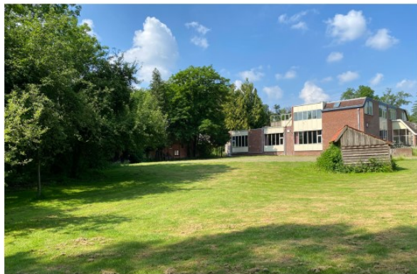
Het projectgebied gezien in de richting van het te slopen gebouw
