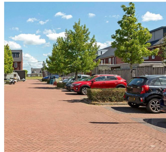
Erftoegangsweg en parkeerplaats van klinkerverharding
