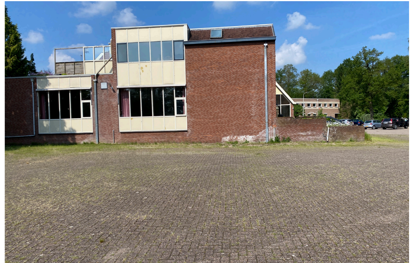
Het te slopen gebouw
