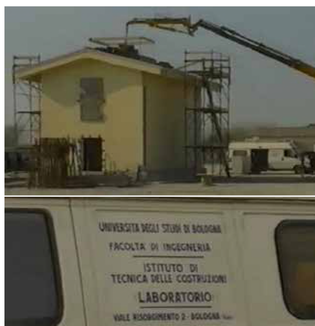
Test uitgevoerd door de Universiteit van Bologna met Vibrodina op een met ISOTEX-blokken en -vloerelementen gebouwde woning.
