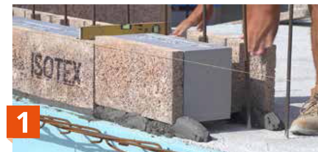
Het waterpas leggen van de eerste rij om te egaliseren.
