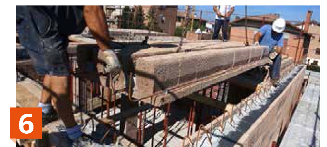
Het leggen van de prefab-vloerelementen.
