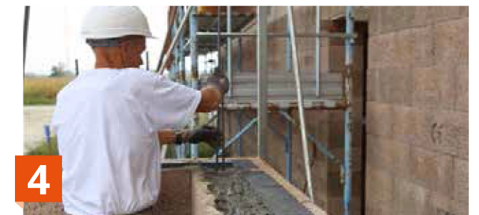
Het aanbrengen van de verticale wapening voor de stabiliteit van de constructie in de verse beton.
