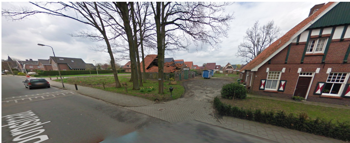
Afbeelding 2.1: straatbeeld planlocatie uit april 2009, zwaar beschadigde schuur zichtbaar (bron: Google Maps)
