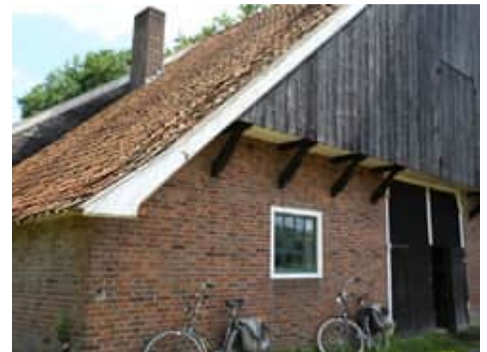
Detail van de topgevel en windveer
