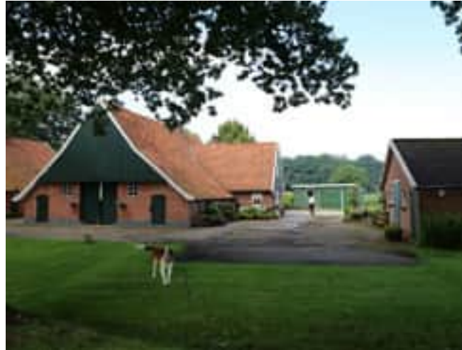
Bestaand erf met boerderij en schuur
