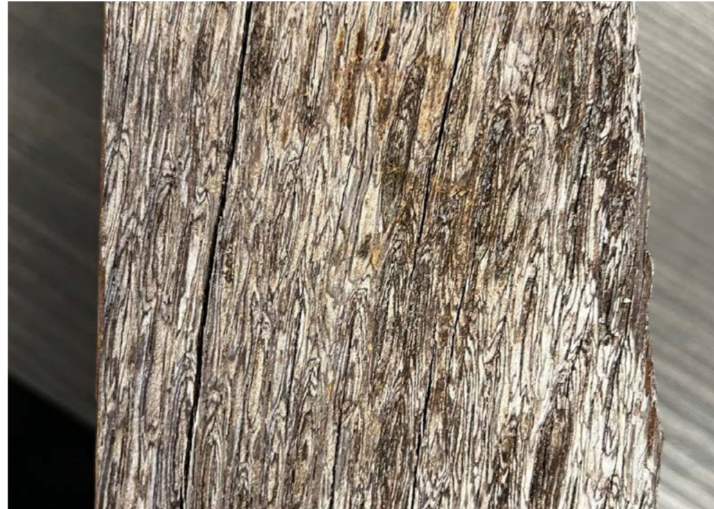
Geogst hardhout voor renovatie bleekbruggetjes
