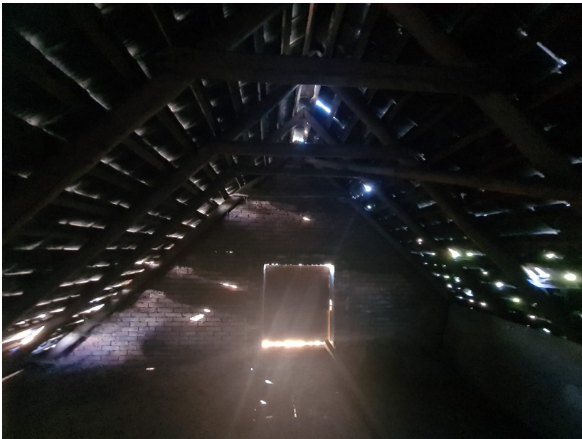
Figuur 7: zolder schuur
