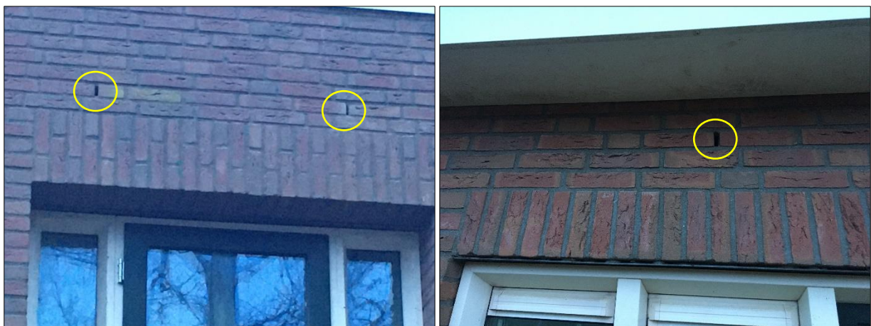
Voorbeelden van potentiële invliegopeningen in de bebouwing.
