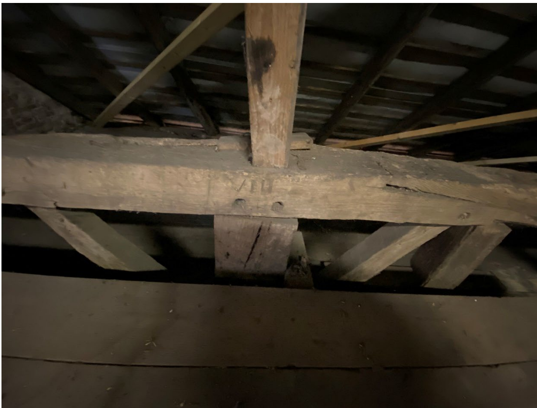
Afb. Gemerkte bovenplaat met gebintstaander en spreibanden
