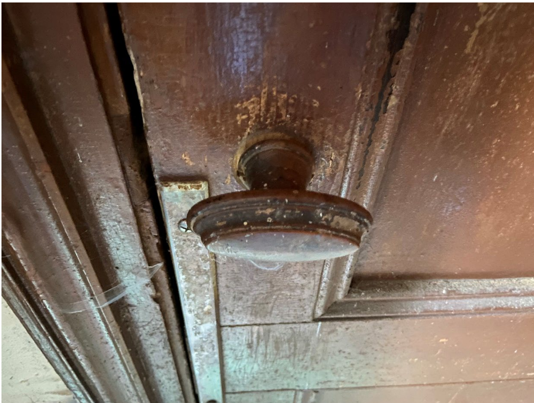
Afb. Paneeldeur in de gang van het voorhuis met een amandelknop deurklink
