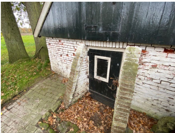
Afb. Vooraanzicht aardappelkelder met verdiepte vloer en lage toegangsdeur
