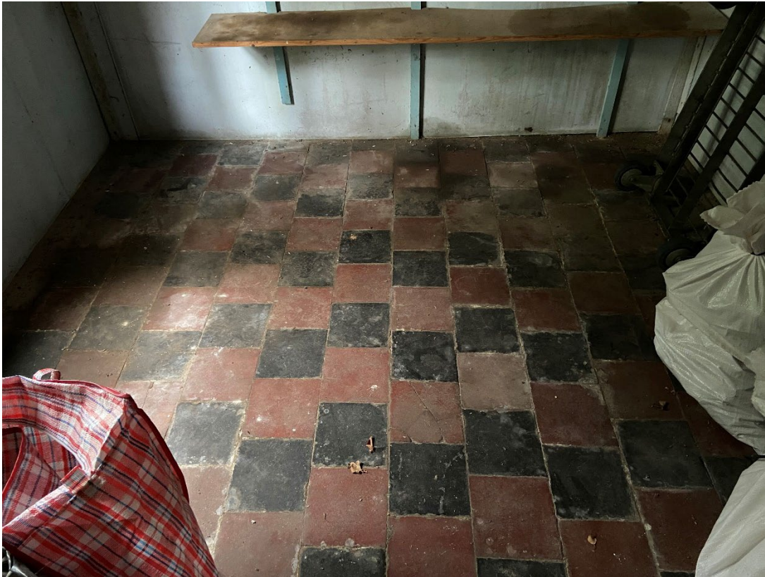
Afb. Kelder in de boerderij met een Estriken vloer in zwart en rood
