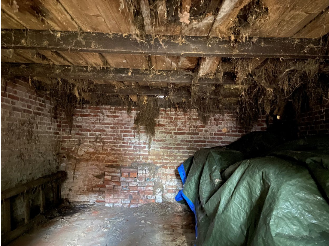
Afb. Interieur aardappelkelder met verdiept aangelegde vloer
