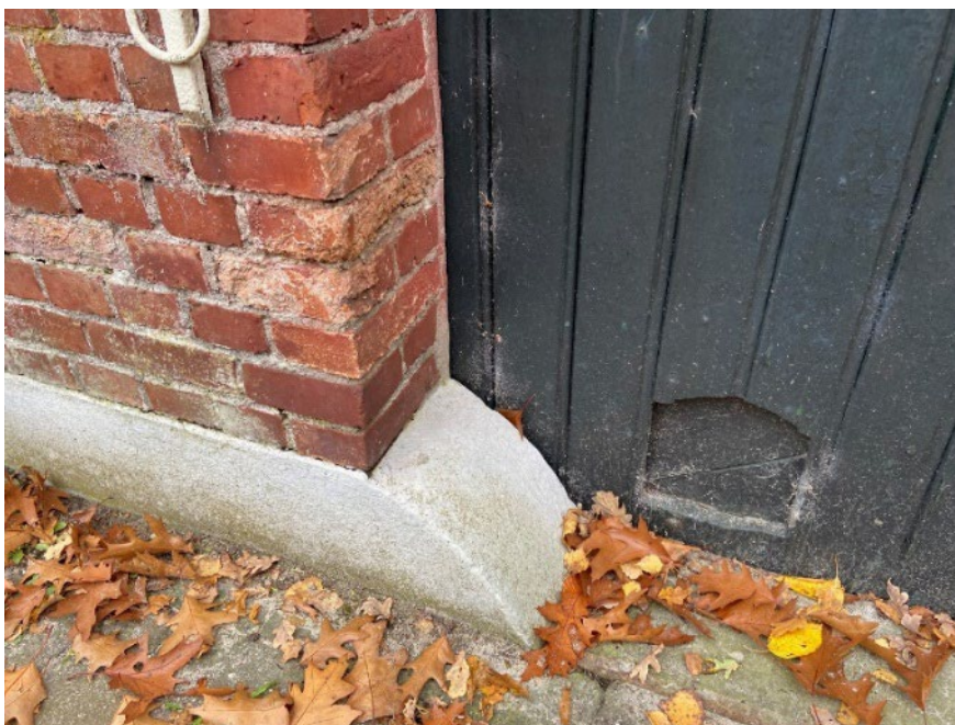
Afb. Veel details zichtbaar, schampsteen ter bescherming van de gevel, een kippen/poezen luijke en een gevelanker met ring om paard of koe aan vast leggen.
