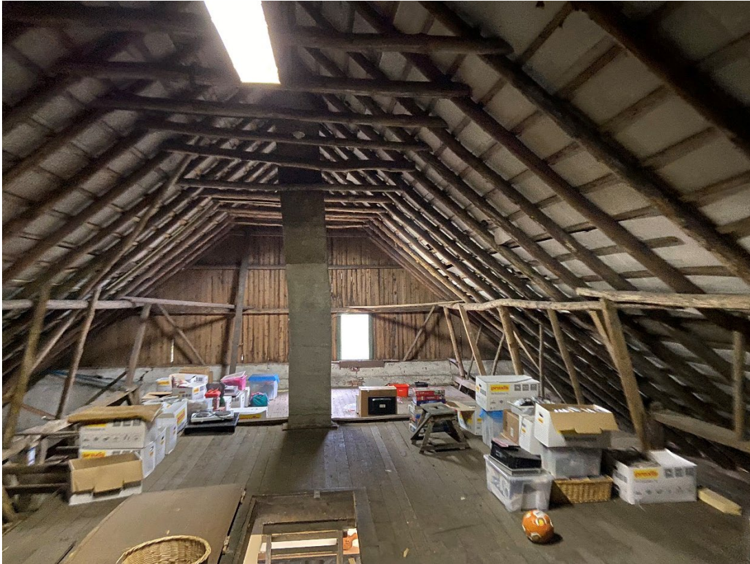
Afb. Zolder van de boerderij met schoorsteenkanaal, en opgehoogde sporen kap
