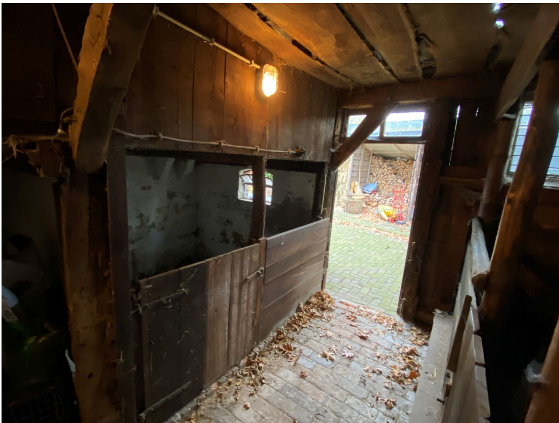
Afb. Interieur van de schuur met hildebeschot en slietenzolder
