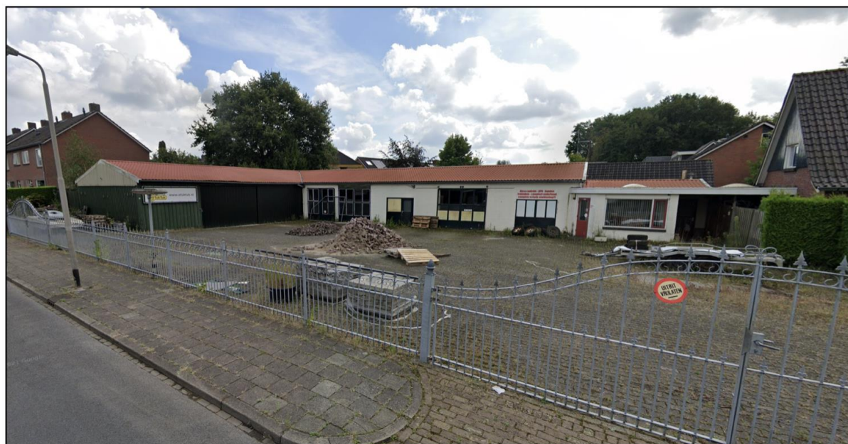
Afbeelding 2.3: Huidige situatie bedrijfsbebouwing, gezien vanaf de Nachtegaalstraat (Bron: Google Street View)
