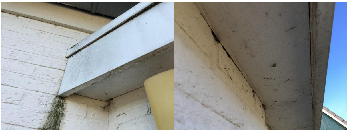
Er zijn geen kieren vastgesteld onder de metalen daklijsten en achter de betimmering van het dak overstek.
