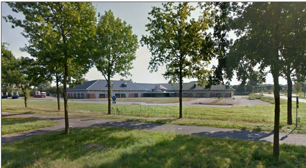
Afbeelding 2.2 Foto huidige situatie centrumgebouw (Bron: Google Streetview; 2016)
