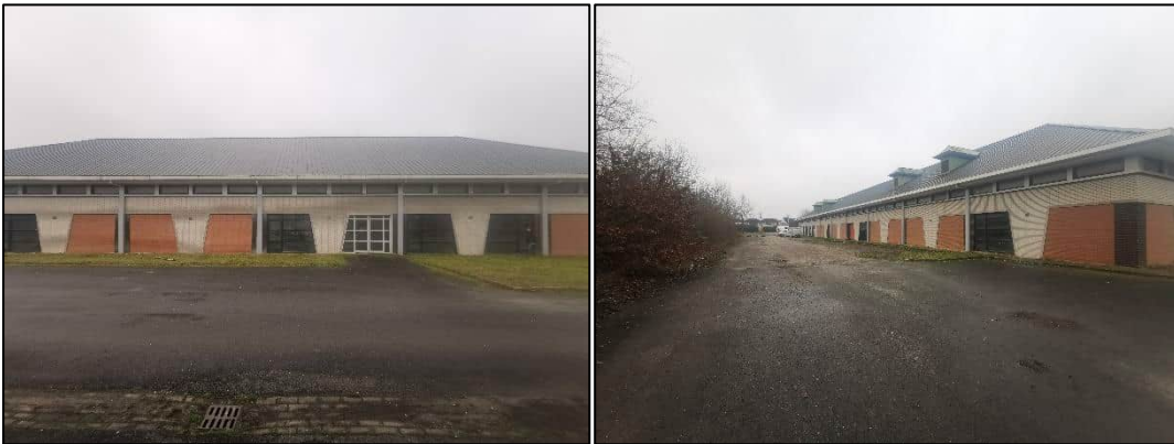
Figuur 2.5 en 2.6: Noordoostaanzicht van het gebouw(links) en oostaanzicht van het gebouw(rechts).
