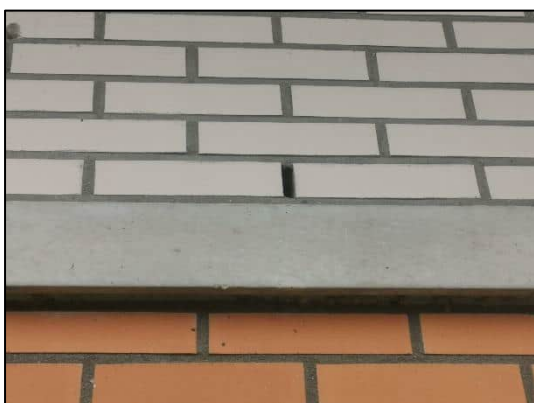
Figuur 1.6: Het gebouw beschikt over stootvoegen.
