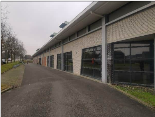
Figuur 2.7: Zuidaanzicht van het gebouw.
